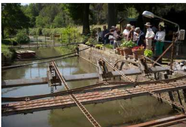
L'ancien dégrilleur devant les bâtiments
